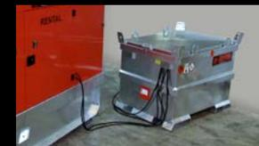
Si une autonomie moyenne de 24 heures n'est pas suffisante, EUROPOWER vous offre des GRV ou réservoirs à double paroi, qui respectent les réglementations UN, ADR, KIWA et Vlare. Ces réservoirs à double paroi sont disponibles de 500 à 3000 litres et différentes options sont possibles.
